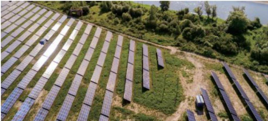
Pemanfaatan lahan bekas tambang sebagai Pembangkit Listrik Tenaga Surya (PLTS)
